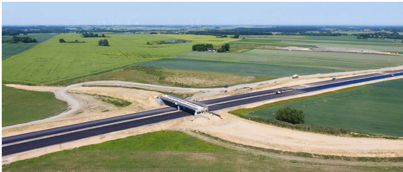
Fot. 1. Budowa S6 na odcinku Kielpino–Kołobrzeg zachód
