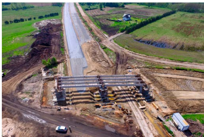
Fot. 3. Budowa S6 na odcinku Kołobrzeg–Ustronie
