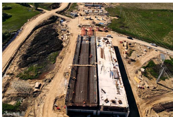
Fot. 5. Budowa obwodnicy Szczecinka
