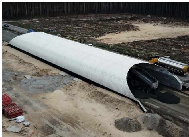
Fot. 6. Budowa A6 na odcinku Dąbie–Rzęśnica (stan na 06.2018)
