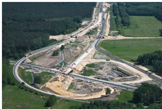
Fot. 2. Północna obwodnica Goleniowa w budowie
